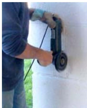
Ouverture au disque segmenté
