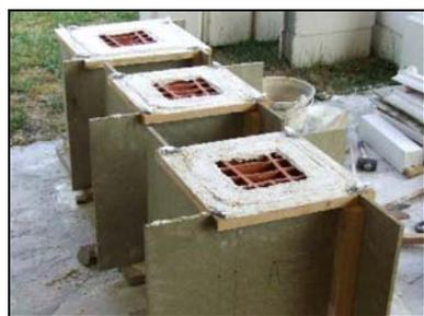
Les 3 moules sont remplis, une base de pilier au fond et deux éléments au premier plan.
