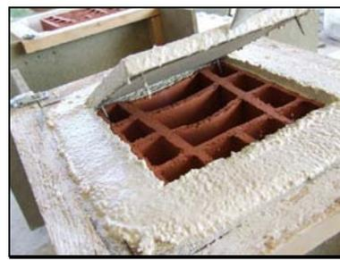
Fin du remplissage. On enlève la plaque. Le mortier doit dépasser de la brique.
