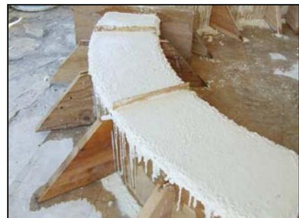
Remplissez à ras bord et vibrez le moule en tapant sur les flancs avec un maillet.
