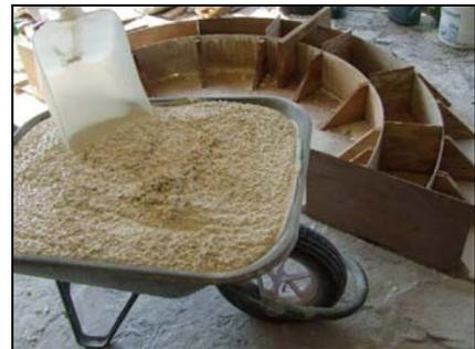
Une pelle confectionnée dans un bidon de pétrole facilite le remplissage.
